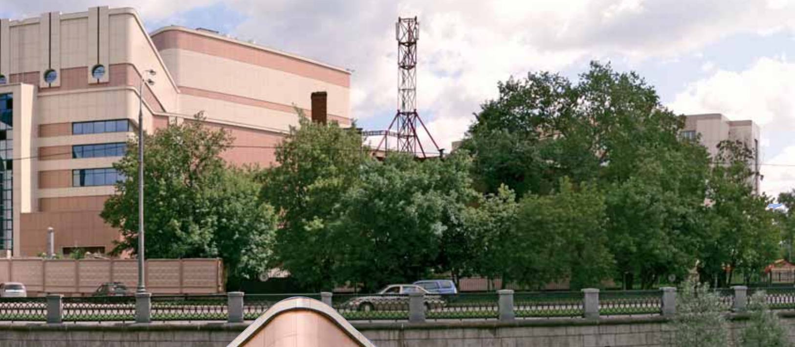
Комплекс зданий ОАО «Электростанция» г. Москва, ул. Электростанционная, 21 Архитектурный проект: А. Рамазанов Монтажные работы: ООО «Ронсон гидрозащита» Подсистема: Navek-040
